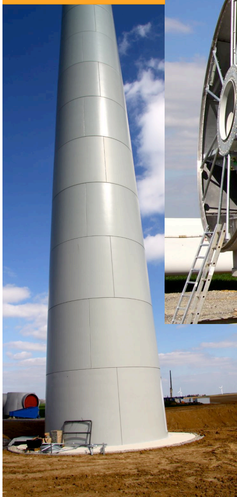
La base de la tour en Béton qui sera surmontée de la tour métallique.
