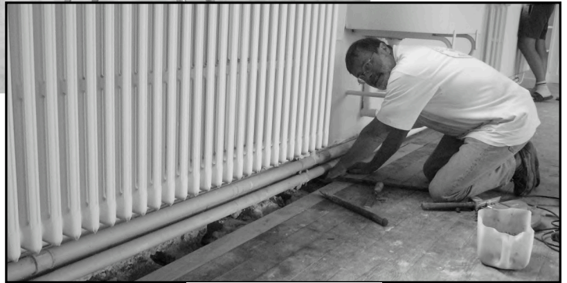
Remise en état du parquet
