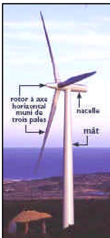
Le mât des éoliennes implantées à Chézy devrait mesurer 100 mètres et les pales 40 mètres. La vitesse optimale du vent tourne autour de 50 Kms/heure et doit être au minimum de 15 Kms/heure. La tête s'oriente automatiquement pour prendre le maximum de vent grâce à un gyroscope.
